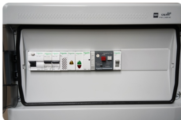
Skrzynka sterująca (z zabezpieczeniem przeciwporażeniowym w postaci wyłącznika różnicowoprądowego oraz wyłącznikiem silnikowym pompy). Dodatkowo wyposażona w alarm świetlny i dźwiękowy oraz przetwornik trybu pracy. Obudowa 18 modułowa o stopniu ochrony IP 65. Do skrzynki podłączane są 3 włączniki pływakowe.
