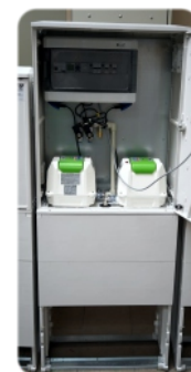
Energooszczędne dmuchawy JDK-S z zabezpieczeniem przebicia membran
