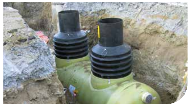
Rys. 32. Studzienka włazowa EuroHUK po zamontowaniu
