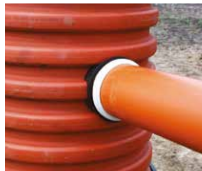
6. Tak zamontowana wkładka in situ gotowa jest do umieszczenia w niej rury kanalizacyjnej.
