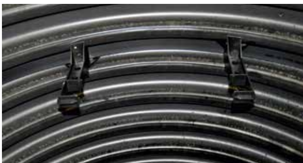
Rys. 5. Premontaż obejmy drabinki w rurze trzonowej
