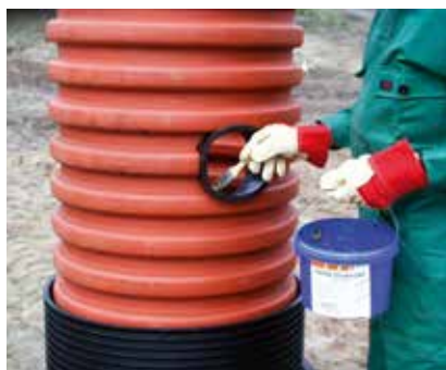
2. Następnie oczyszcza się krawędzie otworu z zadziorów.
