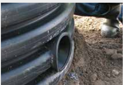
4. W przypadku trudności z montażem krawędzie otworu można posmarować środkiem poślizgowym.
