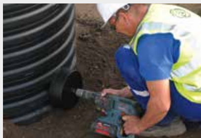
2. Następnie oczyszcza się krawędzie otworu z zadziorów.
