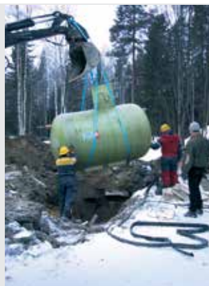
Oczyszczalnie BioKem® 10 EN i BioKem® 15 EN są wykonane z GRP – laminatu poliestrowego wzmocnianego włóknom szklanym.
