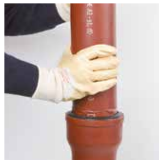
Połącz bosi koniec rury z kielichem upewniając się, że znacznik centralny styka się równomiernie z krawędzią bosego końca rury.
