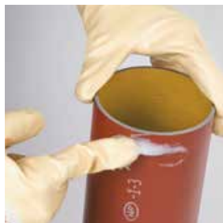
Nałóż niewielką ilość pasty poślizgowej na końcówkę bosego końca rury lub kształtki, a następnie na uszczelkę kielichową.
