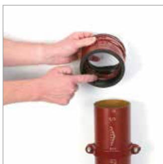
Nałóż niewielką ilość pasty poślizgowej na uszczelkę w kielichu kształtki i końcówkę rury.
