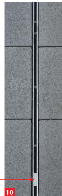
Przykład montażu specjalnej złączki do rusztów szczelinowych.
