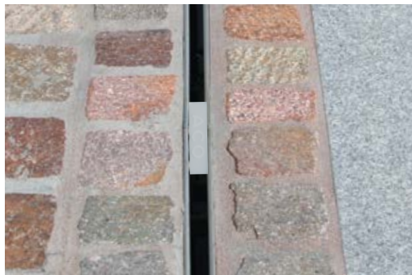
Przykład ram szczelinowych bez zastosowanej złączki oraz z wykorzystaniem tego elementu.
