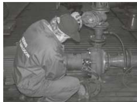
Pompa po zamontowaniu na stacji prób.
