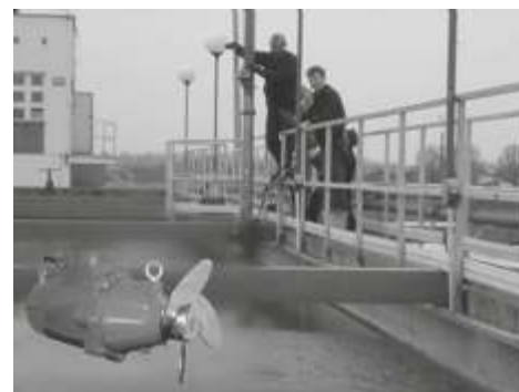
Uruchomienie mieszadeł na oczyszczalni.
